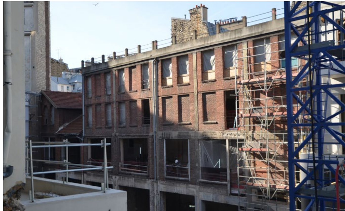
BÂTIMENT INDUSTRIEL_ CHANTIER
