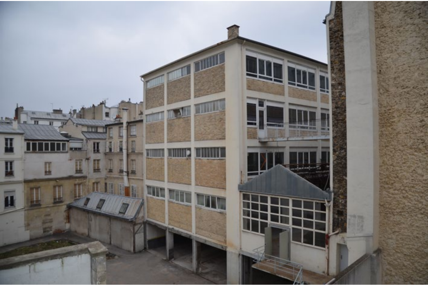
VUE DU CŒUR D'ÎLOT _ ETAT EXISTANT
